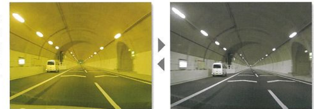
事故・落下物・故障車などの異常発生時に黄色点滅
