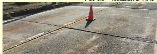
角欠け・段差すり付け
